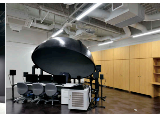
サイエンス & クリエイティブ工房 最先端の機材を設置し 新しい展示やドームシアター番組を開発する工房。照明は TENQOO シリーズ直付形を採用④
