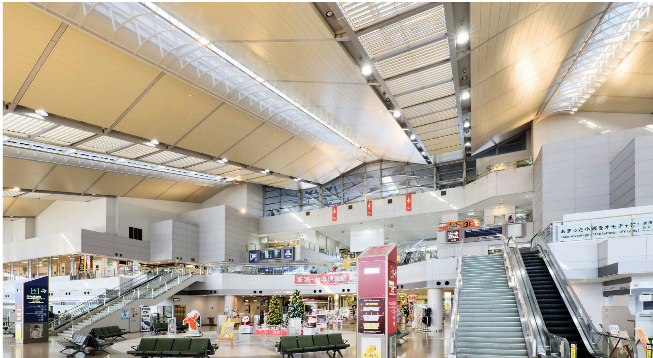
ロビー中央 LED一体形ダウンライト①の昼白色の光が降り注ぎ、LED小形角形投光器②③④の電球色の光が天井を照らす大空間
