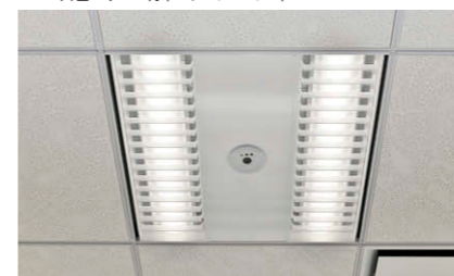
① システム天井用器具グリッドタイプ 白色バツフル付（+あかりセンサー）
