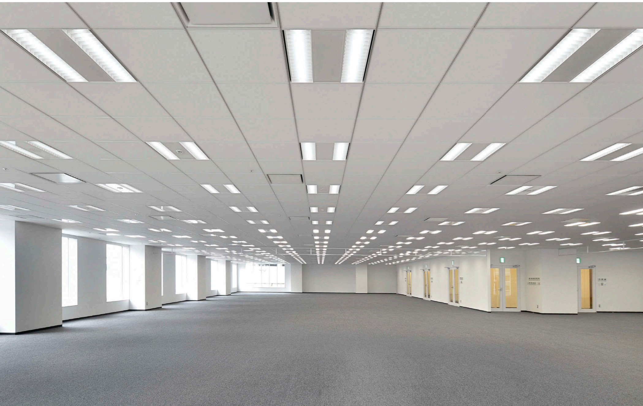
① オフィスフロアの照明 システム天井用器具グリッドタイプ（TENQOOシリーズ）が昼光利用制御されたテナントスペース
