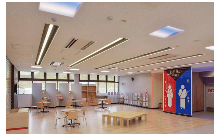
情報・休憩スペースの照明 中央の折り上げ天井に TENQOO シリーズ③を、両サイドに SORAIRO [ソライロ]④を配置し、くつろぎのスペースを提供
