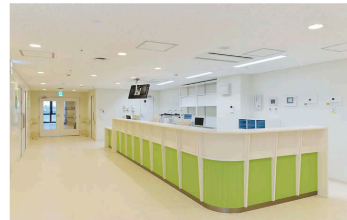
スタッフステーションと廊下の照明 廊下などの共用部にはLEDユニット交換形ダウンライト⑤を配置
