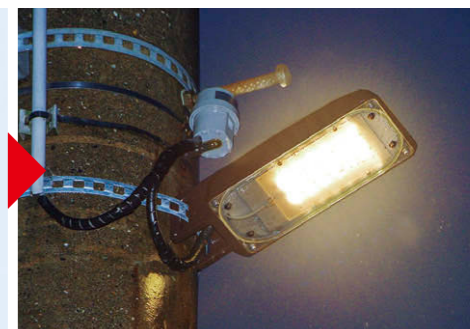
① LED 防犯灯耐塩形 (シティブラウン塗装) 左：消灯時 右：点灯時 本体色を「シティブラウン」に塗装処理した、こまちなみ保存地区の LED 防犯灯
