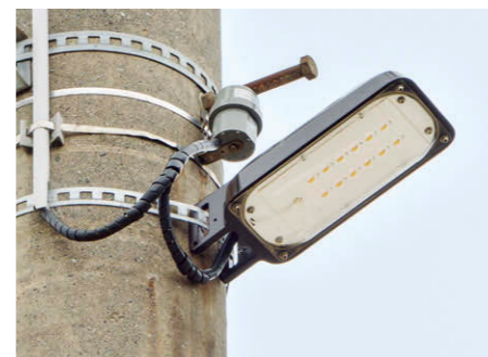
① LED 防犯灯耐塩形 (シティブラウン塗装) 左：消灯時 右：点灯時 本体色を「シティブラウン」に塗装処理した、こまちなみ保存地区の LED 防犯灯
