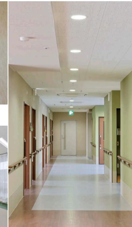
2階廊下のLEDユニット交換形ダウンライト①による照明
