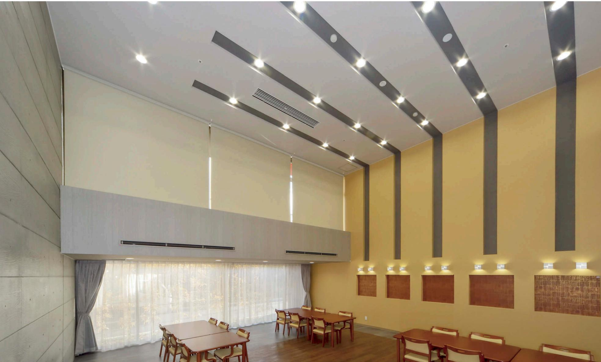
食堂兼機能訓練室の照明 LEDユニット交換形ダウンライト①とLEDブラケット照明④を採用
