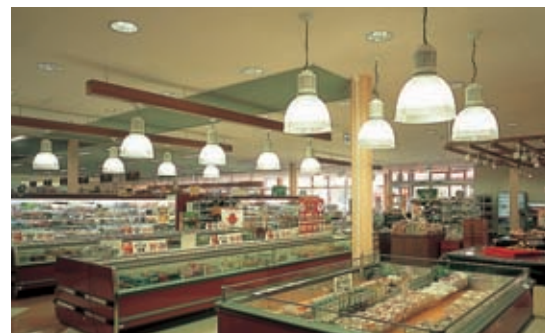
冷凍食品エリアの照明：ロフトペンダントを採用し、明るく、豊富な品揃えと賑やかさを演出
