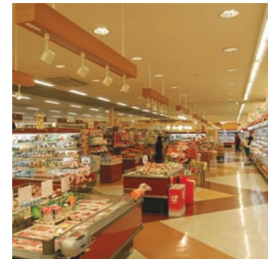
回遊通路に沿って配置されている肉・鮮魚エリアの照明：ハロゲンランプライティングレール用スポットライトが多用されている
