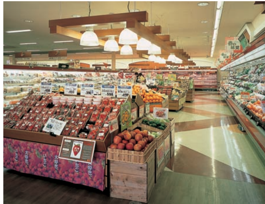
野菜・果実エリアの照明：42Wコンパクト形蛍光灯ランプ3灯用ロフトペンダントを採用し、見やすく、選びやすい光環境を演出
