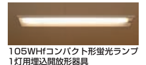
グロッサリーエリアの照明：ベース照明に105WHiコンパクト形蛍光灯ランプ1灯用埋込開放形器具を採用し、簡易照明制御システムSESL II あかりセンサで調光を可能にしている
