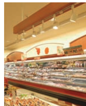
壁面コーナーには105WHiコンパクト形蛍光灯ランプウォールウォッシュ器具で空間に広がり感演出
