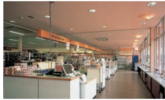
カウンター周りの照明：ベース照明に32Wコンパクト形蛍光灯ランプ3灯用ダウンライトを配置し、包装台には60Wホワイトランプ2灯用シーリングライトにより天井面へ間接光を創り出し柔らかな雰囲気演出
