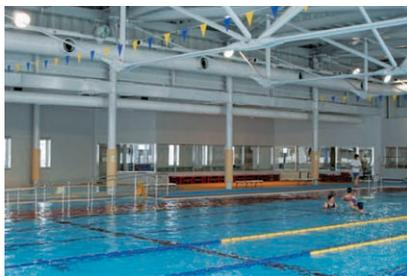
温水プールの照明：プールの両サイド上部のメタルハライドランプサイドライティング器具により斜め下方向照射で照明
