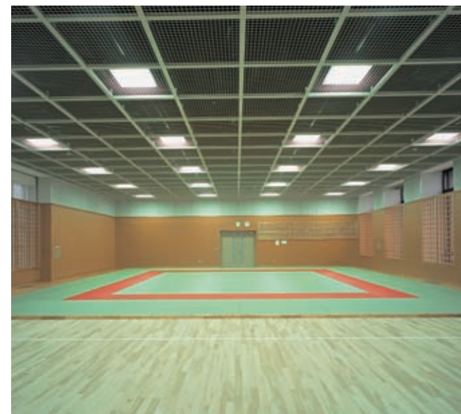
武道場の照明：55Wコンパクト形蛍光灯4灯用スクエア器具を整列配置
