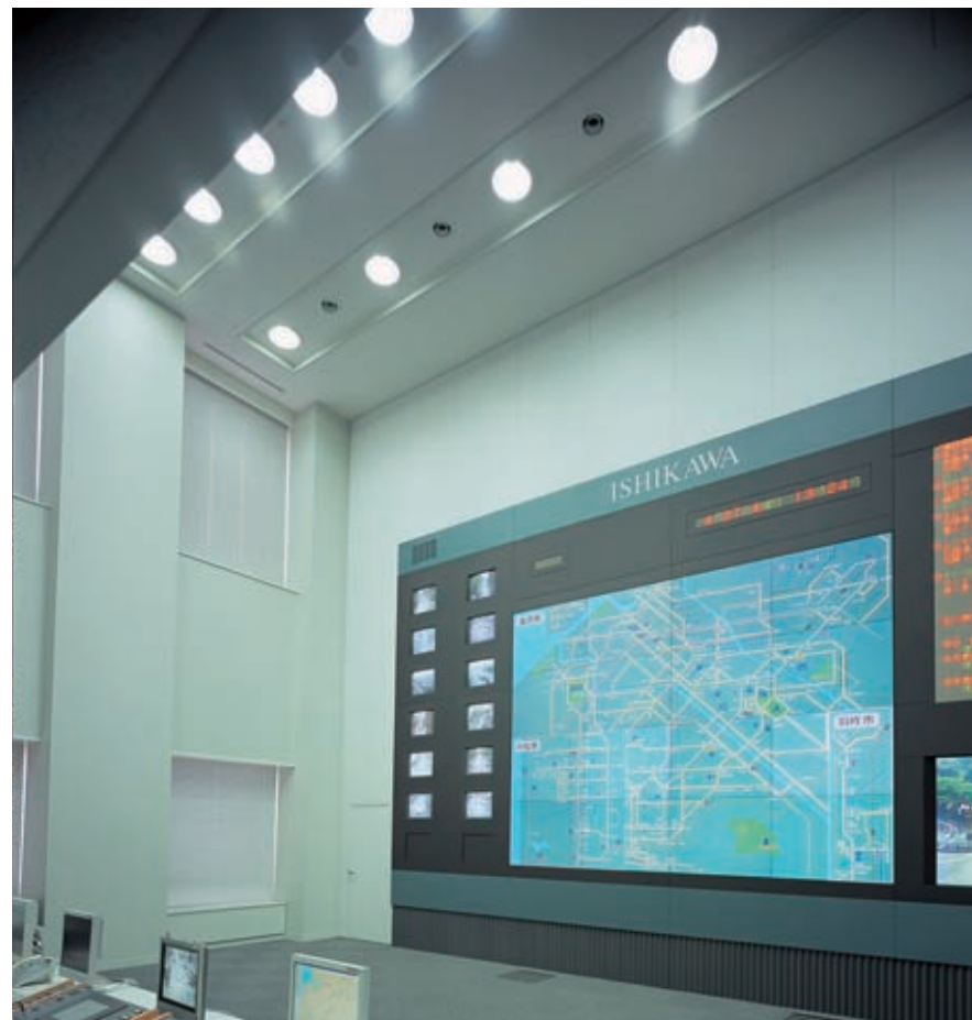
交通管制センターの照明：FHT42Wコンパクト形蛍光灯3灯用埋込器具(昇降装置付)を設置。連続調光を可能としている
