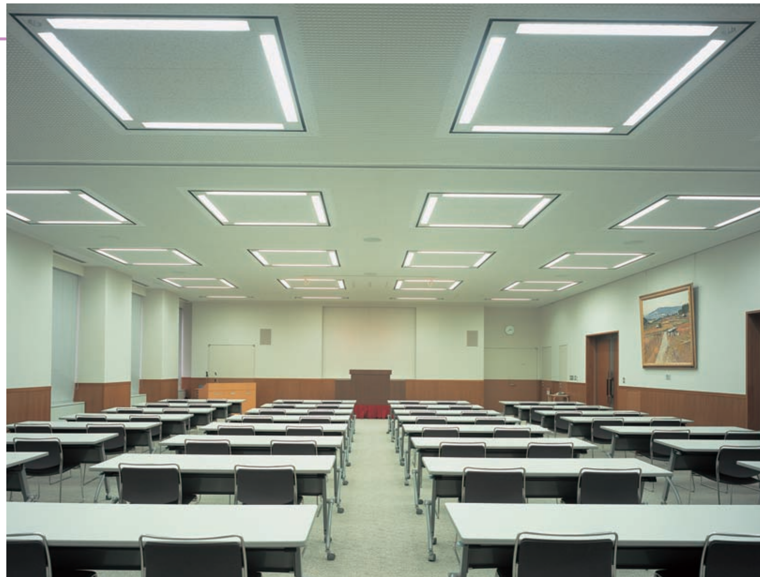
会議室の照明：32WHf蛍光灯1灯用(OALルーバ付)口の字器具を採用。照度分布にムラがなく、VDT表示面の映り込みも防止、あかりセンサを採用し省エネが図られている
