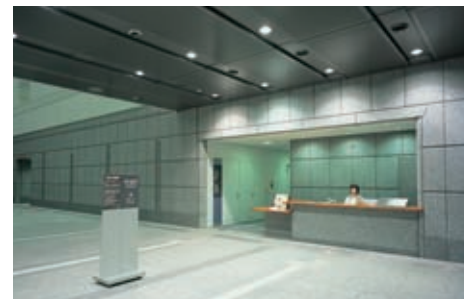
エントランスホール受付周りの照明
