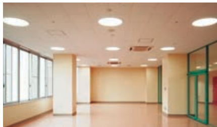
トレーニング室の照明：55Wコンパクト形蛍光ランプ4灯用下面乳白カバー付器具を設置
