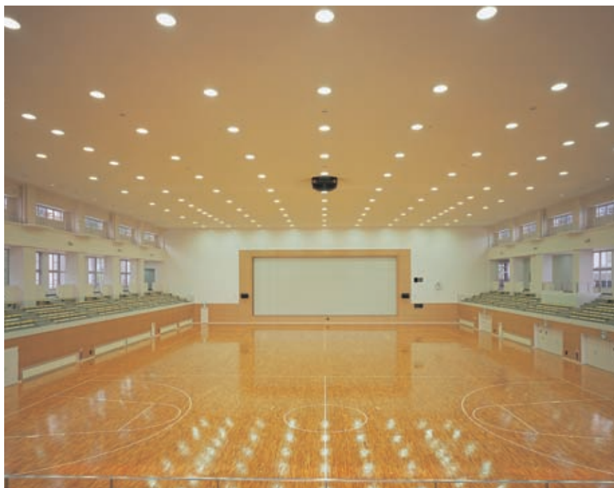
メインアリーナの照明：1kWメタルハライドランプ電動昇降装置付ダウンライトを均等に分散配置
