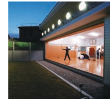
弓道場の照明：400W水銀ランプ投光器7台を採用
