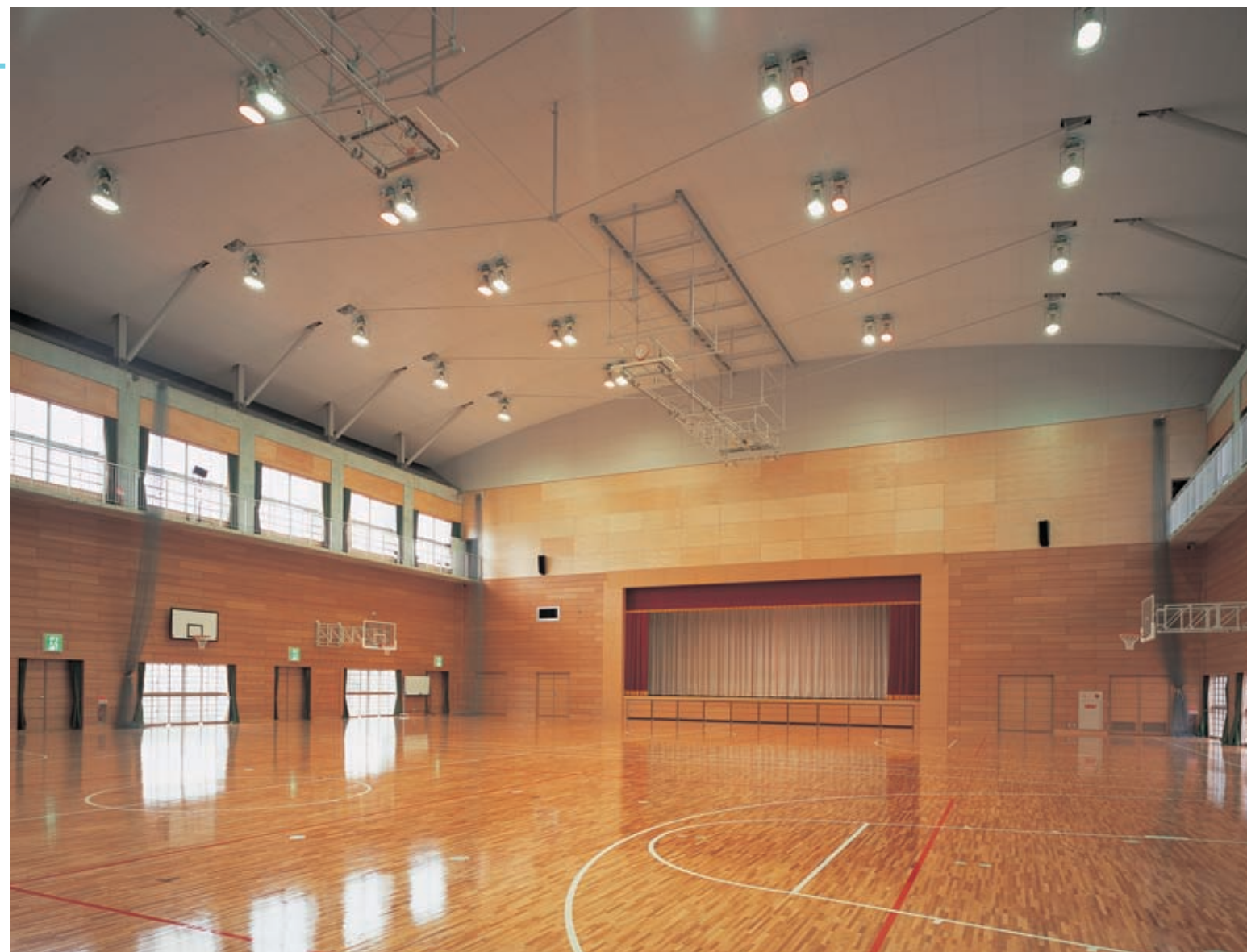
体育館メインアリーナの照明：300Wセラミックメタルハイドランプ・500Wハロゲンランプ混光照明器具を採用。ハロゲンランプは調光可能でイベントにも対応
