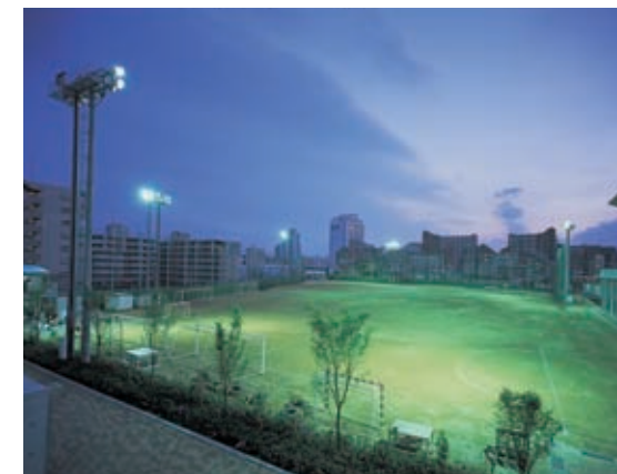
グラウンドの照明：7基の照明塔に1.5kWメタルハイドランプ投光器を合計84台設置
