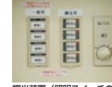
調光装置(照明スイッチのアップ)
