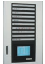
照明制御システム (MESL-S) 主操作盤
