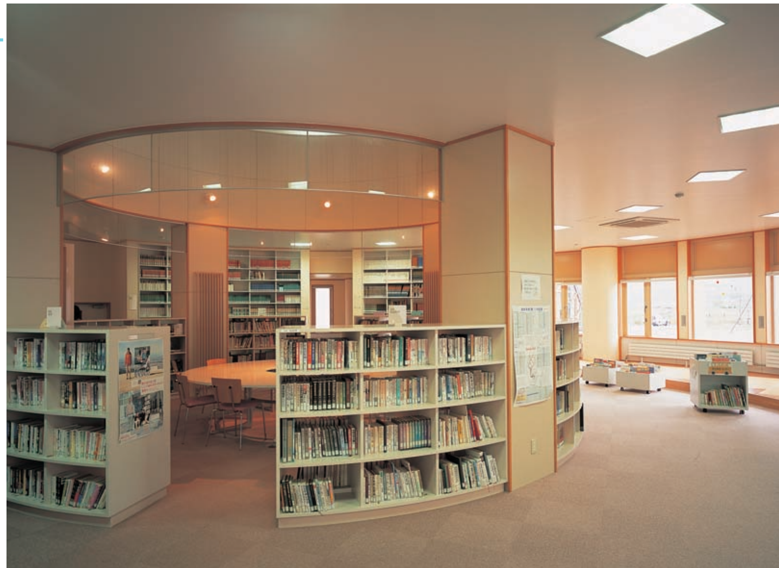
図書室1階の照明：建築意匠に合わせて1階には55Wコンパクト形蛍光ランプ4灯用と36Wコンパクト形蛍光ランプ3灯用のスクエア器具を放射状に配置。円形状の吹き抜け部分にはスポットライトを採用
