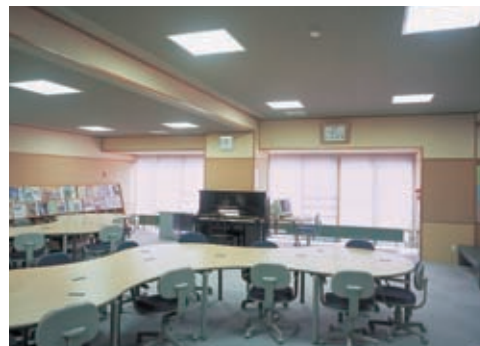
パソコン教室の照明：32WHf蛍光ランプ2灯用OALルーバ付埋込器具を採用し、目の負担を軽減しながら十分な明るさを確保
