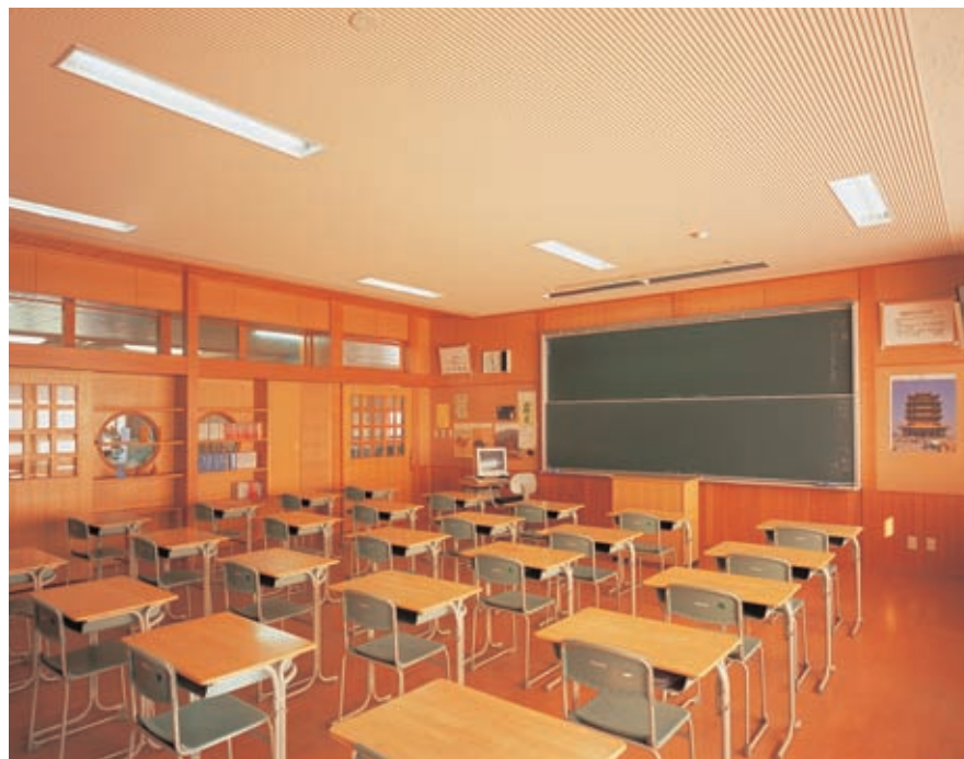
普通教室の照明：32WHf蛍光ランプ2灯用埋込器具とあかりセンサを採用。昼光利用制御、廊下側と窓側の明るさの均一化を図っている
