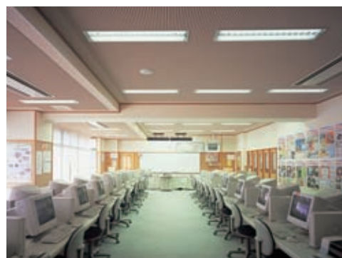
パソコン教室の照明：32WHf蛍光ランプ2灯用OALルーバ付埋込器具を採用し、目の負担を軽減しながら十分な明るさを確保
