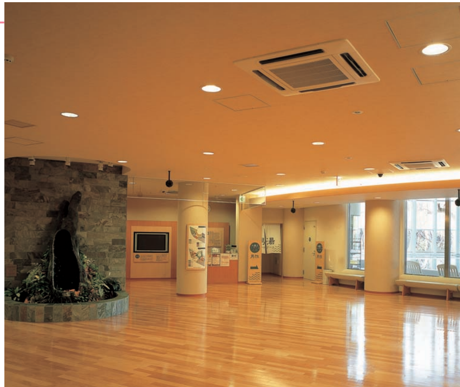
1階エントランスロビー：42Wコンパクト形蛍光ランプ2灯用ダウンライトをメインに構成。室内周囲には間接照明の柔らかな明かりで広がり感を演出
