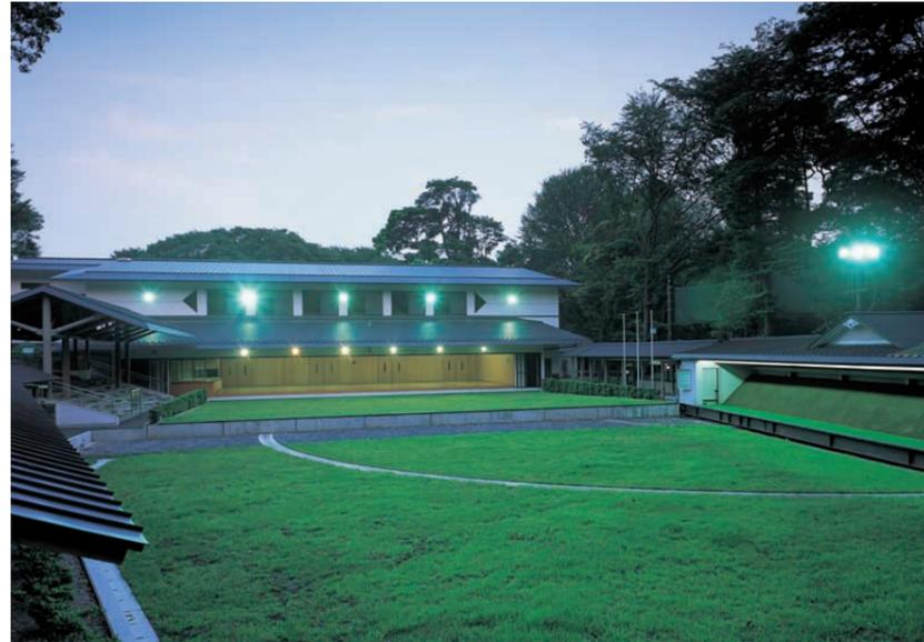
遠的方向から射場方向を望む 1、2階の軒下に投光器を設け夜間の矢道照明としている
