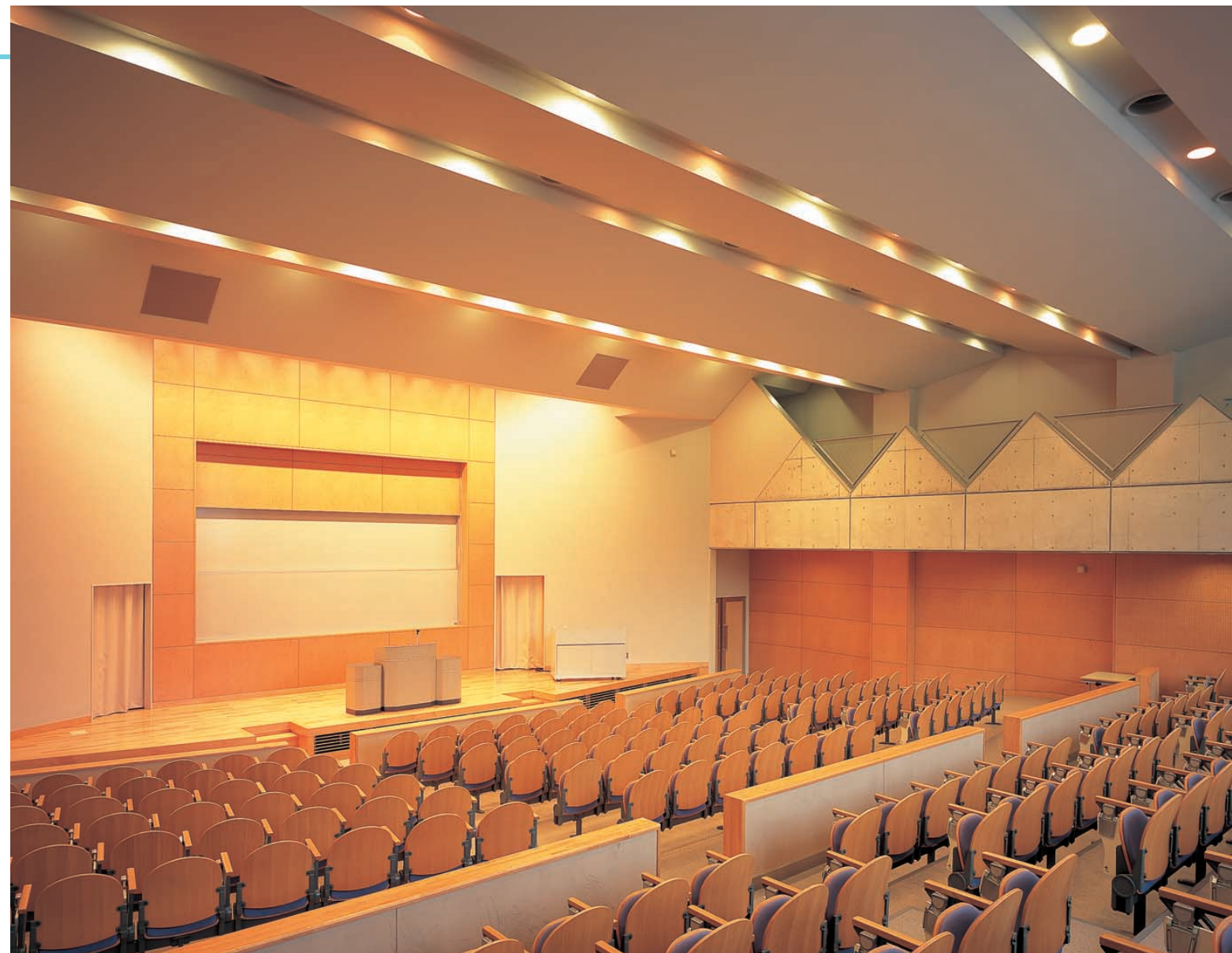
300人教室 多用途に対応できるよう32Wユーライン3・3灯用とHID埋込器具を交互に配置。調光操作器により多彩な照明パターンを可能にしている Classroom with 300 seats
