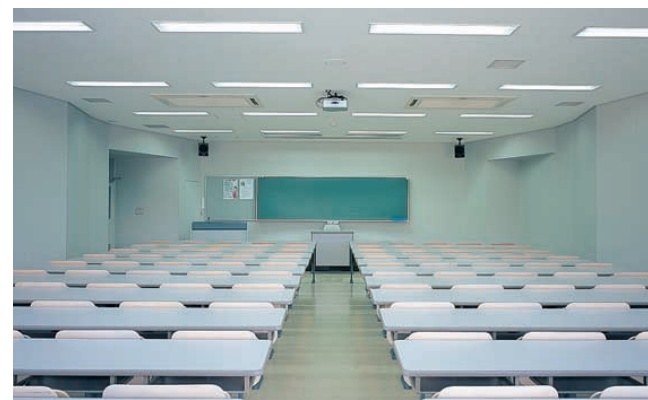
120人教室 HF32W2灯用埋込器具により、明るく照度ムラのない学習環境を得ている Classroom with 120 seats
