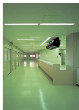
クリーン病室の廊下：40W1灯用クリーンルーム用埋込器具を採用 Corridor of clean hospital rooms
