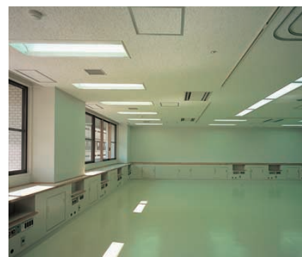
人工透析室：ベッド上の仰向け状態を配慮して、32WHf2灯用間接照明器具ソフテリアを使用している Dialysis room
