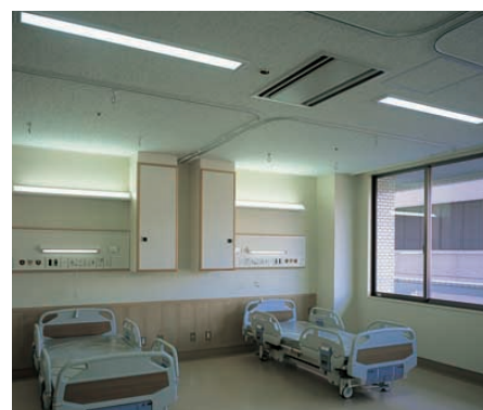
4床病室：32WHf埋込器具をベース照明に、各ベッドごとの壁面照明には上部配光形(段調光付)のブラケットを設置。常夜灯にはLEDダウンライトを使用している A 4-bed hospital room
