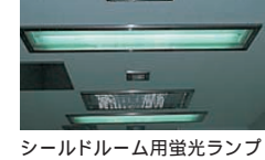
シールドルーム用蛍光灯ランプ埋込器具 Embedded fluorescent lamp appliance for shield room
