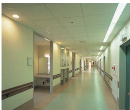
4階病室の廊下：ストレッチャーで運ばれる患者がまぶしくないように壁面コーナーに照明器具を配置 Corridor of hospital rooms on the 4th floor
