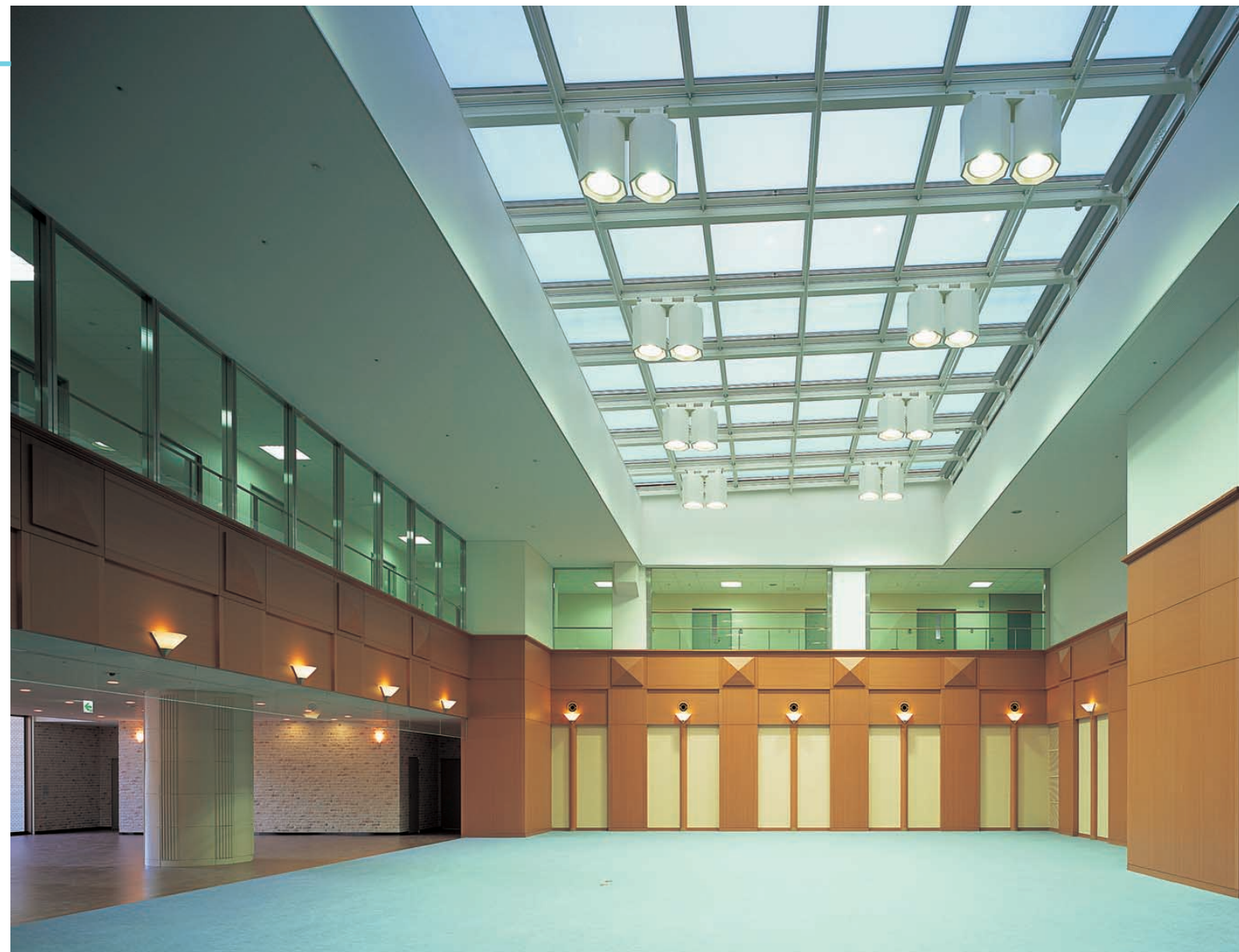
ホスピタルホール：400Wメタルハライドランプ2灯用バンクライトを設置し、外光との違和感がなく、明るく、開放的な照明環境をつくり出している Hospital hall
