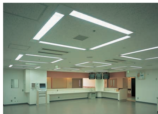
ナースステーション：32WHf埋込器具(OAルーバ付)を口の字形配置にし、作業効率を妨げずに明るく快適な雰囲気を得られている Nurse station
