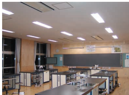
理科3教室：Hf埋込器具を採用。ローカル制御あかりセンサーにより、窓際1列の光出力が制御されている。
