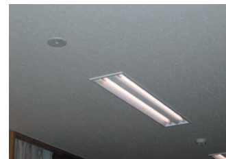
コンピューターーム：ルーバ付のHf埋込器具を採用し、机上面1010ℓxの高照度設計。
