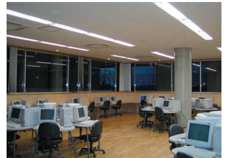
コンピューターーム：ルーバ付のHf埋込器具を採用し、机上面1010ℓxの高照度設計。
