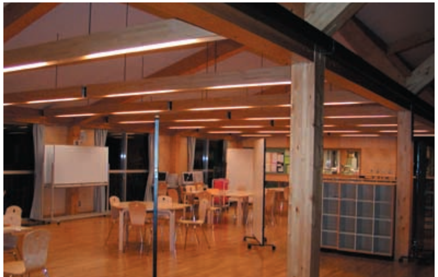
数学オープンスペース：柱に見立てた木枠の中にHf器具を設置。消灯時は器具の存在を意識させないナチュラルな空間を創出。
