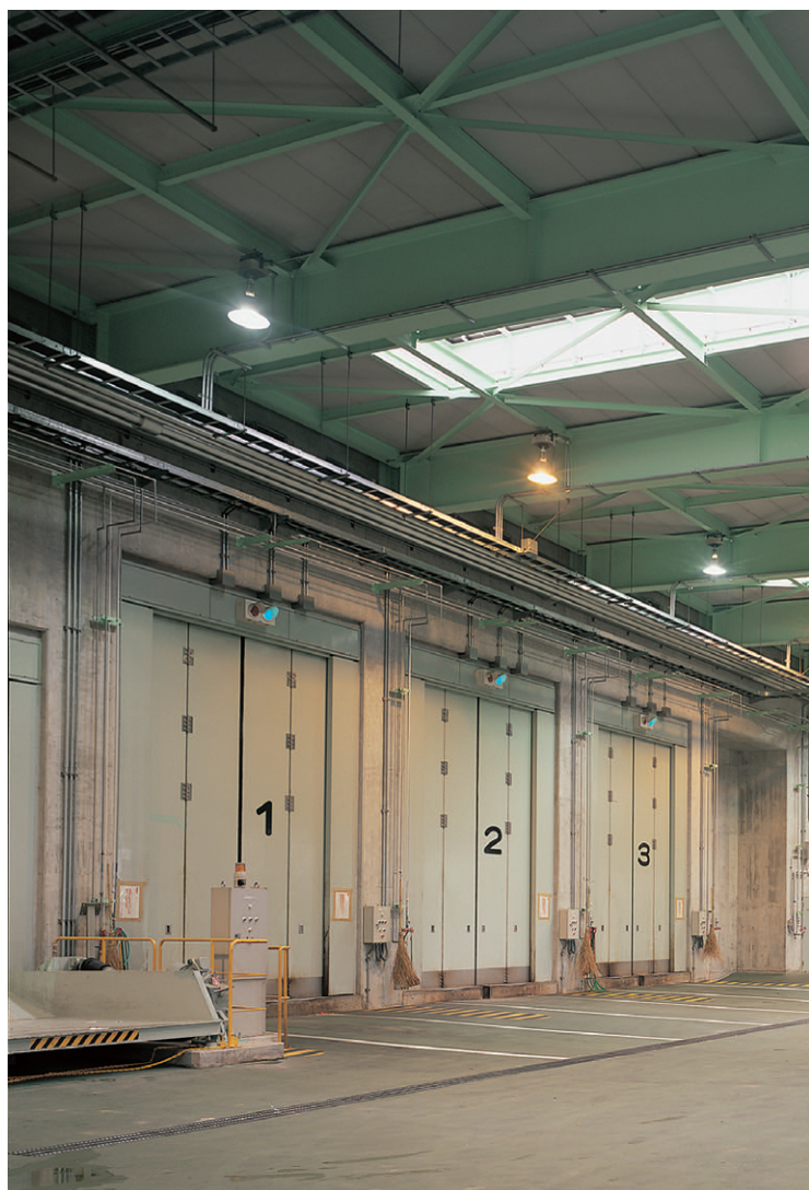
ゴミが搬入されるプラットフォーム：電動昇降装置付高天井用反射笠器具で高効率形の400Wメ
