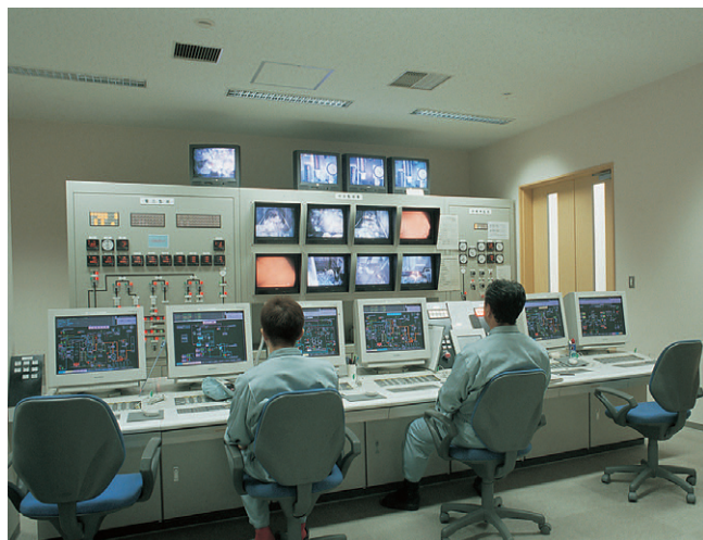
中央制御室：OAブルーバ付きのHf32W2灯用システムアップ器具でディスプレイへの映り込みを防止
