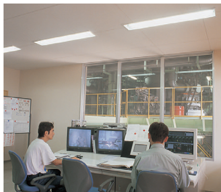
溶融制御室：Hf32W2灯用白色バツフル付器具を使用
