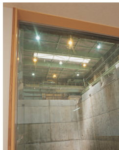
見学者ホールからゴミビットを望む：プラットフォーム同様の混光照明
