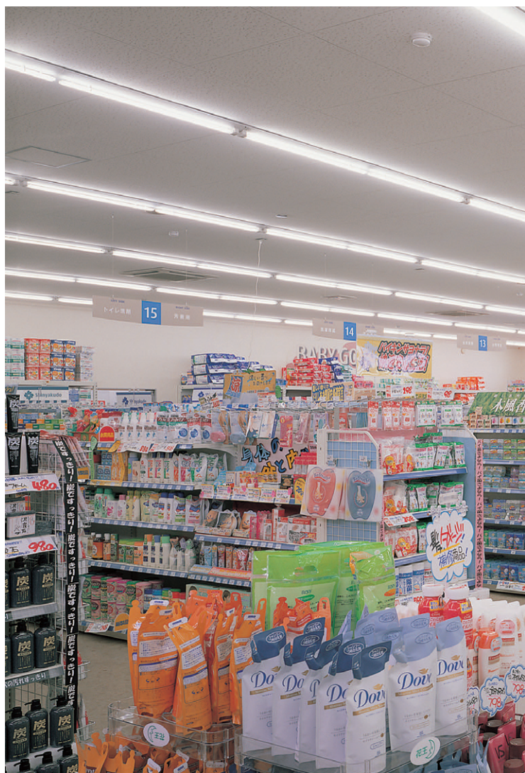
店内：FHP105W蛍光灯直付器具“HfユーラインS”を139台設置
