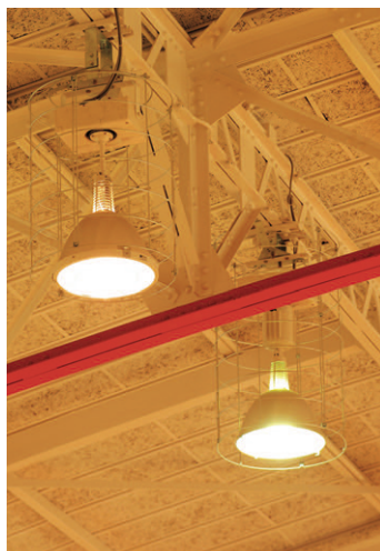
器具にはボール等が当たることを考え、ガードを付けて破損防止としている
