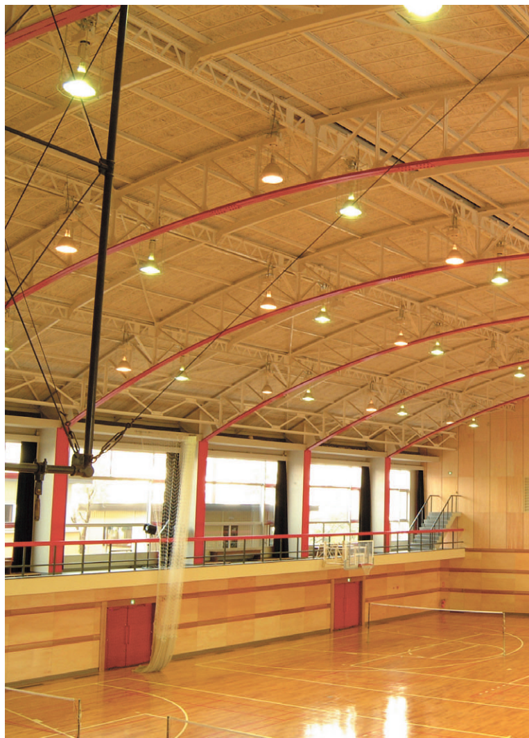
オートリレー付高天井用器具を全部で60灯設置。400W水銀ランプと500Wネオハロゲンランプ
