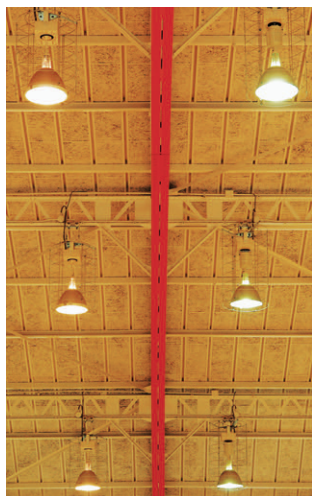
天井の赤く塗られた梁に沿って、400W水銀ランプと500Wネオハロゲンランプを左右に配置
