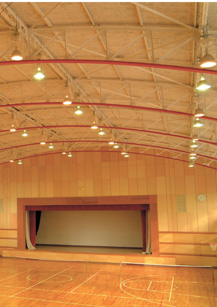
をベアにし、それぞれ30灯ずつ配置して混光照明にしている
