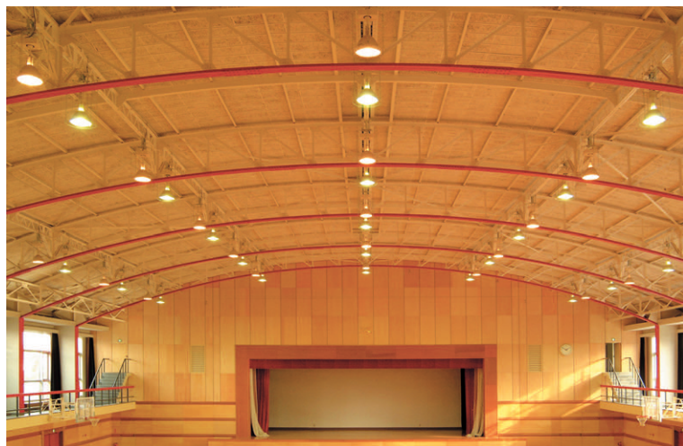
器具色と天井色を同色にし、すっきりとした天井を演出
