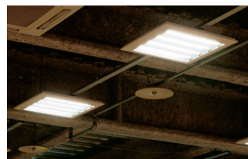
器具の取り付け状況
