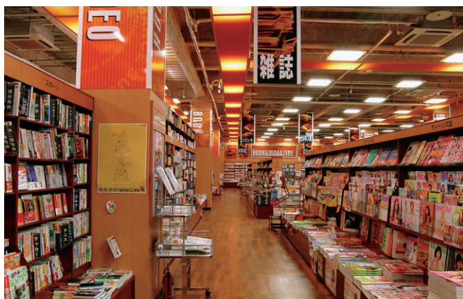
壁際や通路部などにはアクセントとして、オレンジ色の鋼板ルーバーを使用
