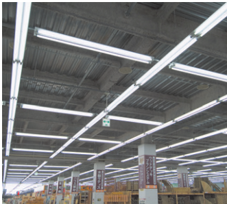
1階資材館の天井部
