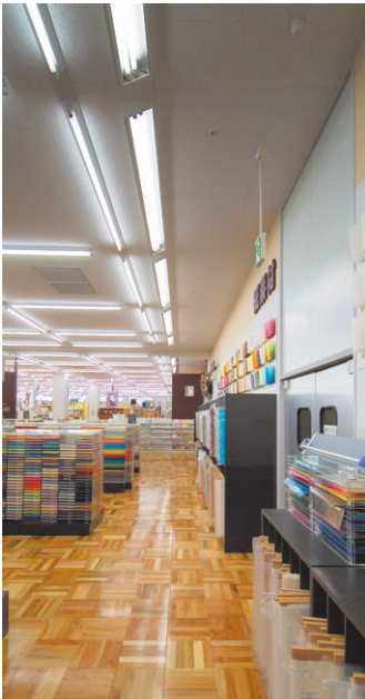
壁際に設置された110W蛍光ランプウォールウォッシャー
