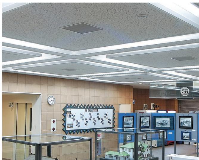
1Fホール：32W Hf蛍光ランプ間接トラフ器具を使用し、開放感のある天井面を実現
