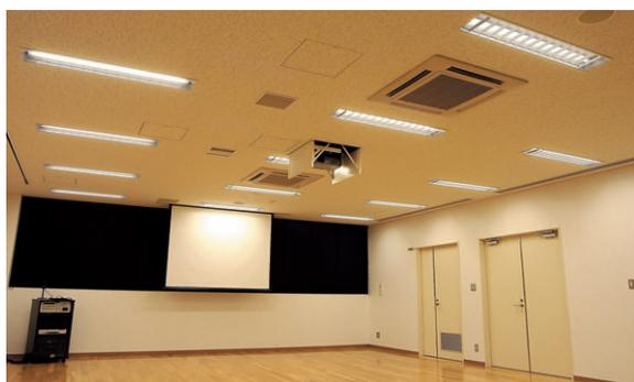
多目的研修室：32W Hf蛍光ランプ埋込器具（ルーバ付）を18台設置
