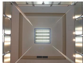
1Fホール吹き抜け：オートリレーにより器具が下降する
