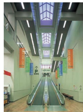
2、3階駐車場へ誘導するオートスロープ廻りの照明：400Wメタルハライドランプ埋込器具10台を設置
