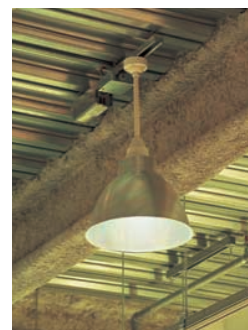
アウトレットモールの店内のベース照明は250Wメタルハライドランプフロフトペンダントが採用されている
