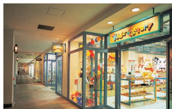
回遊通路の照明：100Wレフランプ埋込ダウンライトを設置
