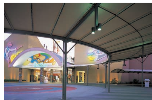
サブゲート通路に設けられたペンダント
