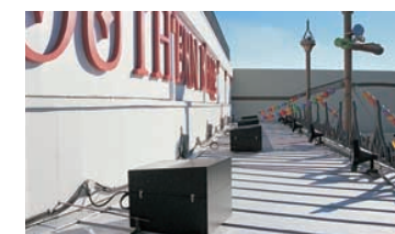
船体にゆらぎの光をつくり出す壁面照射用器具
