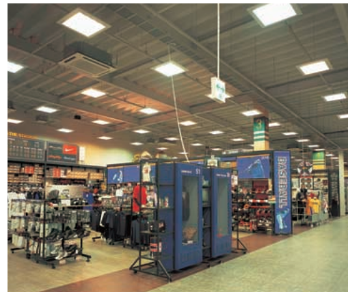
外周ゾーンの売場：55Wコンパクト形蛍光ランプ薄形直付ベースライトを配置し、明るく均斉度の高い配光が得られている
