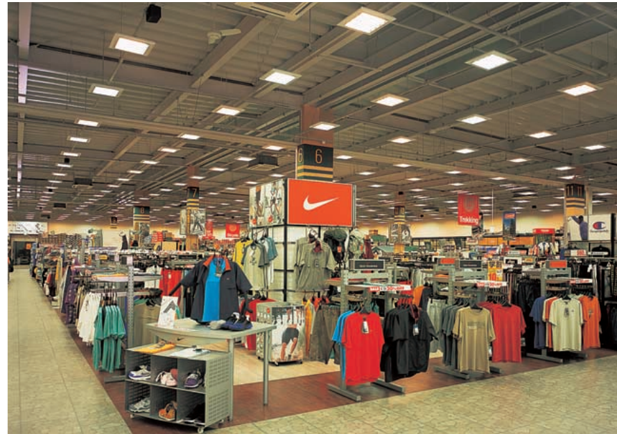
店内出入口側から奥を望む。内周ゾーンには36Wコンパクト形蛍光ランプ薄形直付ベースライトを、外周ゾーンには55Wコンパクト形蛍光ランプ薄形直付ベースライトを設置
