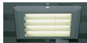
36Wコンパクト形蛍光ランプ電球色の直付薄形ベースライト
