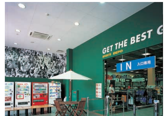
エントランスホール：FHT42Wコンパクト形蛍光ランプ3灯用埋込ダウンライトを設置
