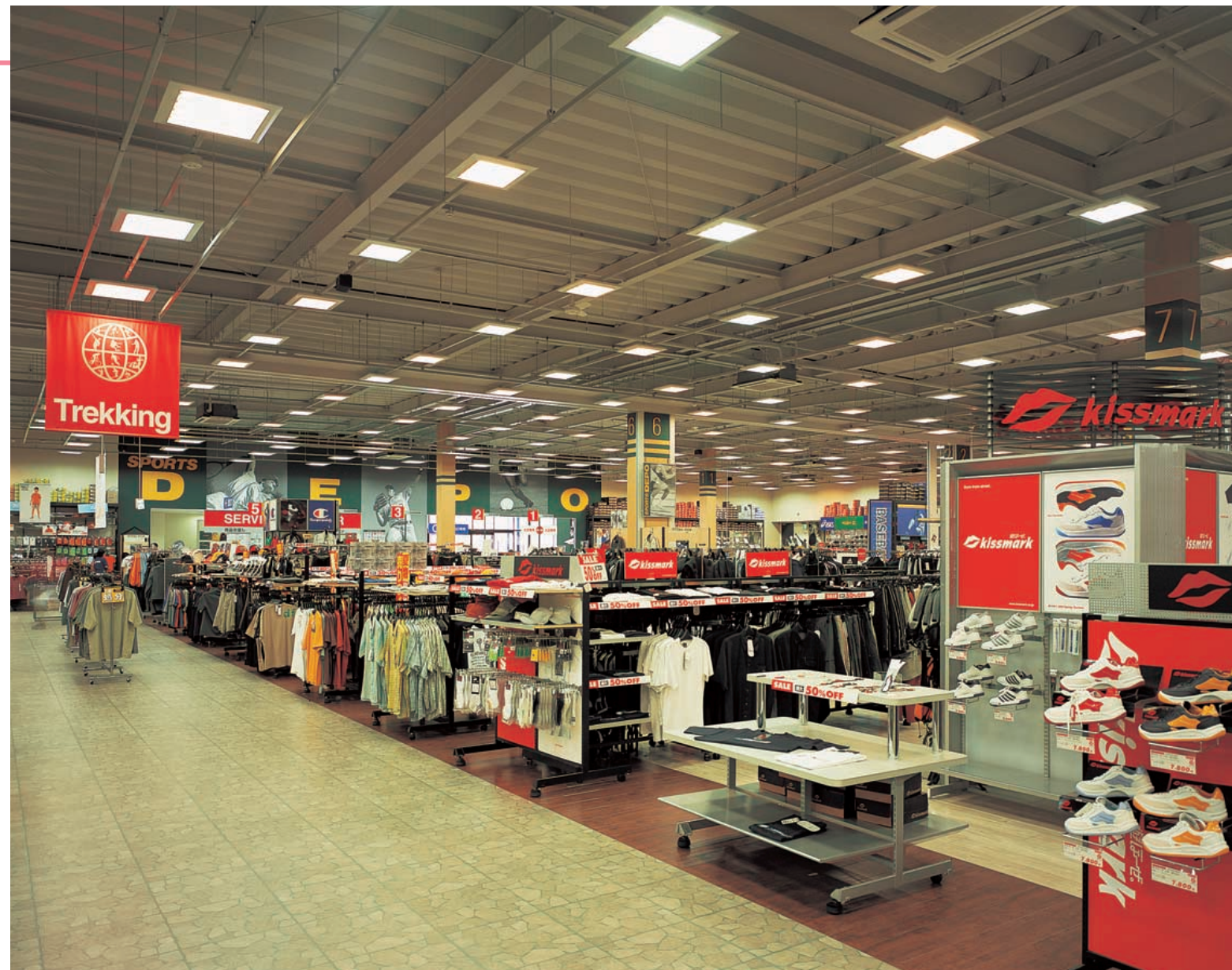
店内奥から入口方向を望む。内周ゾーンは36Wコンパクト形蛍光ランプ直付薄形ベースライトを2.5mピッチでレースウェイに設置
