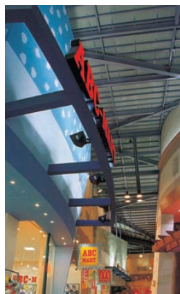
モール中央センターコートの照明：150Wセラミックメタルハライドランプ投光器でファサード部を照明し、センターコートの明るさ感を高めている
