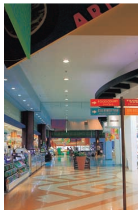
モール内通路照明：ハロゲンダウンライトから、長寿命でかつ高効率な42Wユーライン3・3灯用埋込ダウンライトにリニューアルされた
