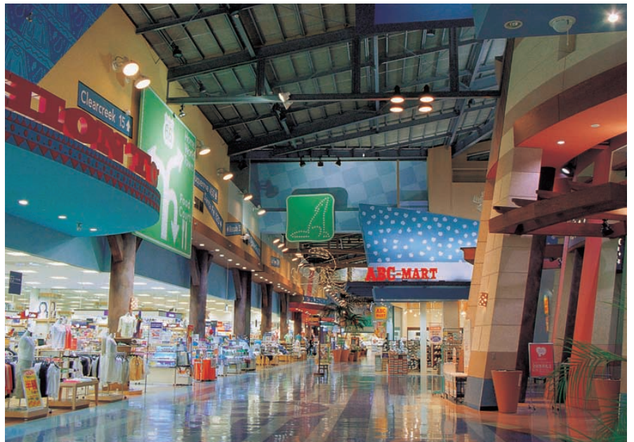
モール内通路の照明：400W高演色形高圧ナトリウムランプ投光器を通路部壁面6~8m高さに設置して、メンテナンスを容易にし、オブジェ用には150Wセラミックメタルハライドランプ投光器を設置
