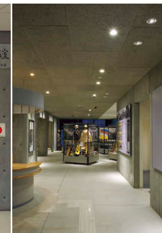
エントランス 展示室に続くLEDユニバーサルダウンライト(埋込形)①による照明。
