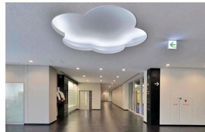
ロビーと廊下の照明 廊下は主にLEDユニット交換形ダウンライト③を採用し、ロビーには折り上げ天井をLED屋内用ライン器具⑤で演出。
