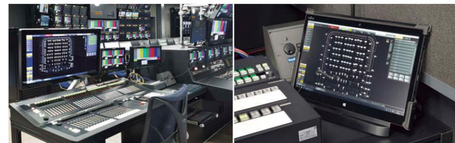
①フルLED専用調光操作卓 Aスタジオ、Bスタジオ共に同一の調光操作卓を導入。 ⑧ワイヤレスタブレット操作器 調光操作卓と同じ画面、同じ操作性で、調光・ボタン昇降の操作が可能。
