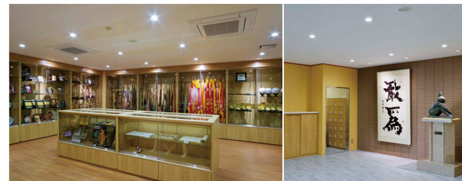
展示室／エントランスホール ベース照明には5000KのLED一体形ダウンライト④を採用／トロフィーなど壁の展示物は4000KのLED一体形ユニバーサルダウンライト⑤で演出。
