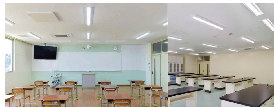
普通教室(左)／理科室(右) TENQOO直付形①により床面最大850～1100ルクス超の明るい学習環境を実現／ホワイトボードの照明には発光部が生徒の目に入りにくい構造の学校用黒板灯②を3灯設置。
