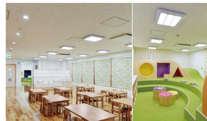
多目的ホール(左)/図書コーナー(右) 影が生じにくく絵や字が見やすいスクエア器具①による照明環境。/多目的ホール通路側にはLED一体形ダウンライト③を整列配置。
