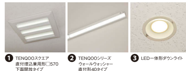
遊戯室(大写真:エントランス側より/右下写真:テラス側より) 白い天井にスッキリとなじむ薄形設計のTENQOOスクエア□570①を等間隔で配置/高天井部壁面にはTENQOOシリーズウォールウォッシャー直付形②を連結設置。
