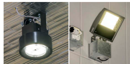
① 特注仕様の LED 丸形高天井器具 ⑤ LED 小形角形投光器
