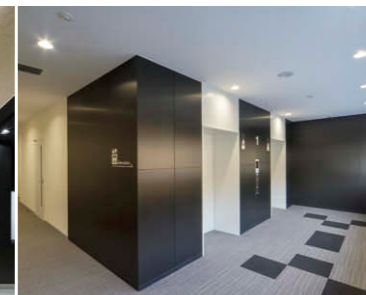
廊下・エレベーターホールの照明 昼白色の LED ダウンライト③により洗練された空間を演出。
