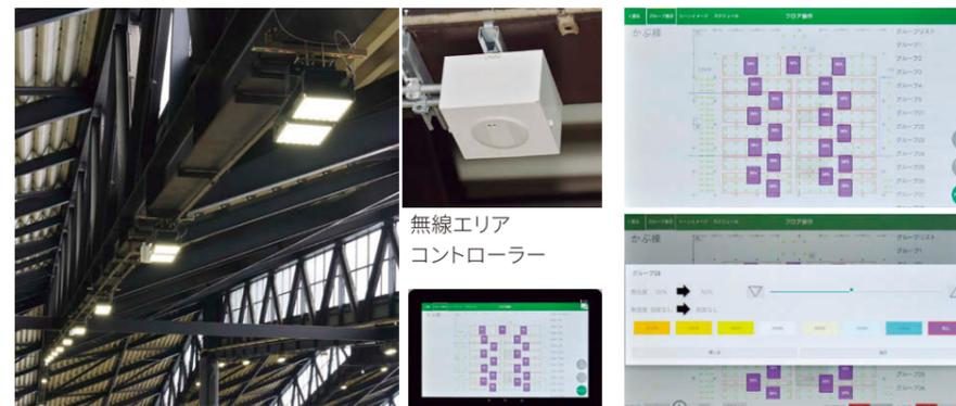
鉄骨トラスに設置された無線T/FlecsシステムLED高天井器具①
