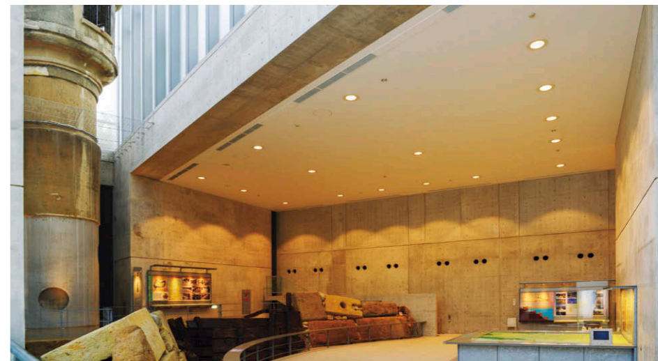
1階展示室 リニューアルプレートによりφ400mmの既存埋込穴にφ300mmの電源別置形LEDライトエンジンダウンライト③を設置。
