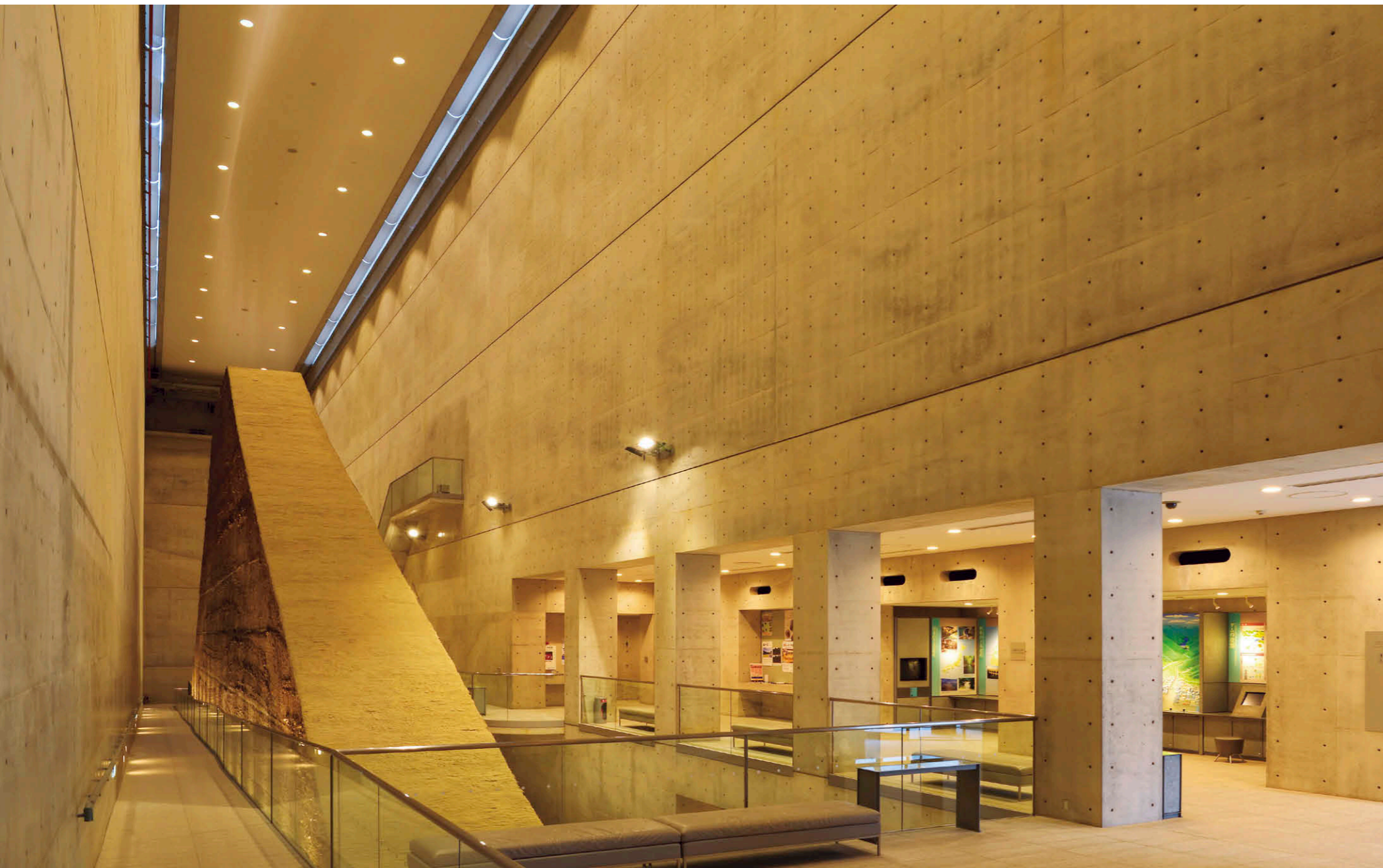
1階展示室 リニューアルプレートによりφ400mmの既存埋込穴にφ300mmの電源別置形LEDライトエンジンダウンライト③を設置。
