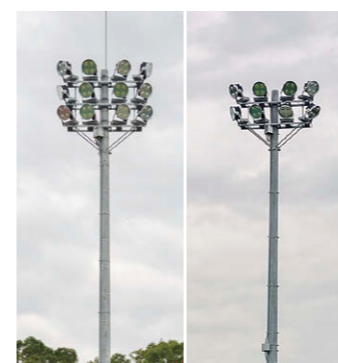
LED投光器12台搭載のAフィールド照明塔消灯時(左)① LED投光器8台搭載のB・Cフィールド照明塔消灯時(右)②
