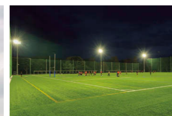
CフィールドのLED投光器全点灯時。
