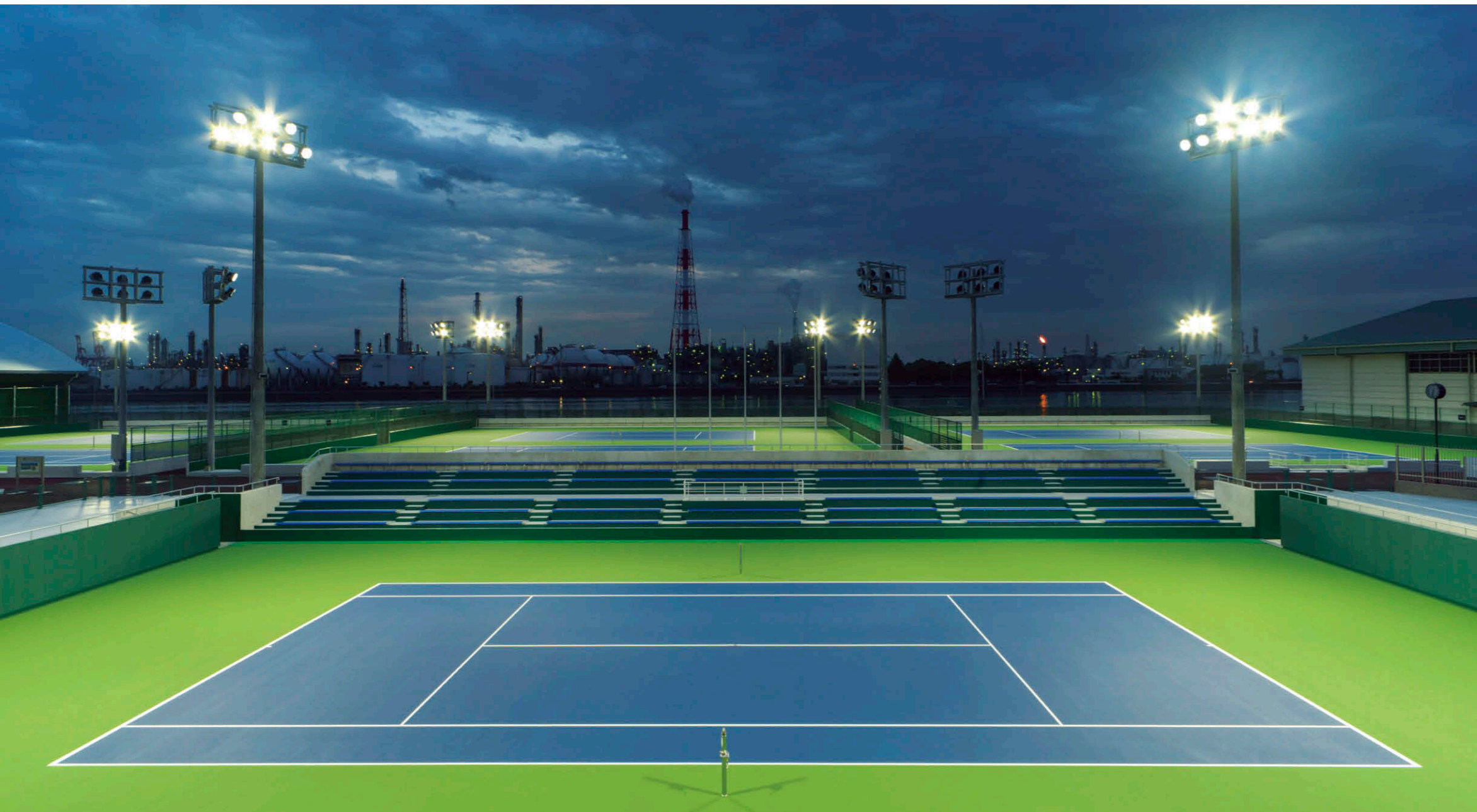
センターコートの照明 コート面からの高さ約17～18mにグレアを抑える最適角度に調整されたLED投光器②を1塔8台、計32台配置。
