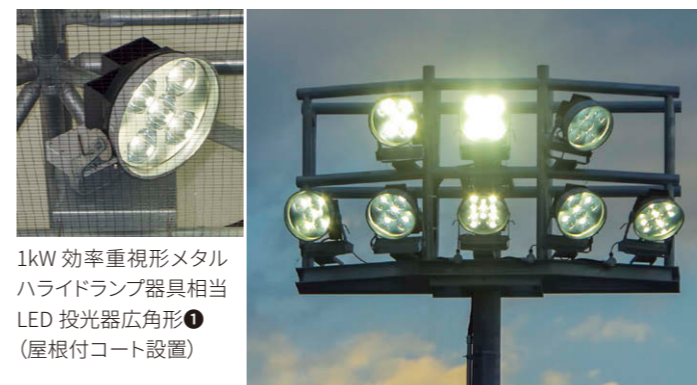
センターコートの照明 コート面からの高さ約17～18mにグレアを抑える最適角度に調整されたLED投光器②を1塔8台、計32台配置。
