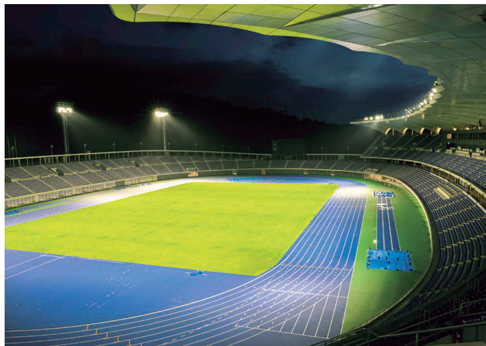
スタジアム全景 高出力2kW相当LED投光器①②により創出された陸上競技場の照明。
