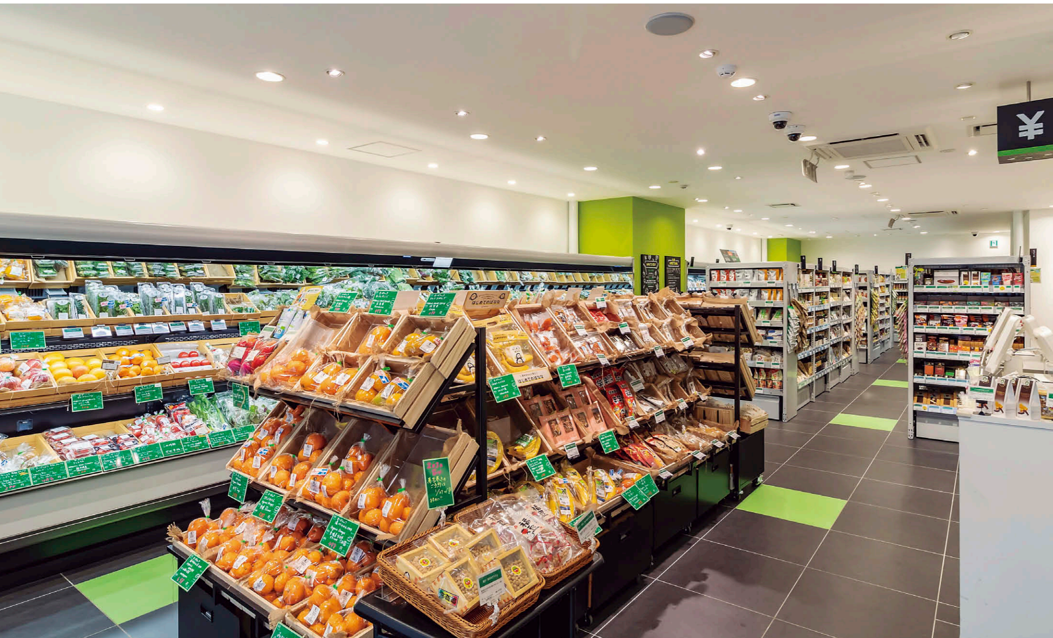
農産コーナーを演色性重視タイプのユニバーサルダウンライト③で照射し、素材がもつ鮮やかな色味を忠実に再現することで、彩り豊かな印象を創出する1F入口。
