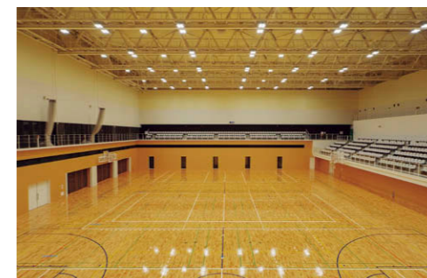
メインアリーナと同仕様の LED 高天井器具を採用 武道場には拡散カバー付下面ガード (黒色塗装仕様) した開放的なサブアリーナ③ 装備の LED 高天井ダウンライトを採用④
