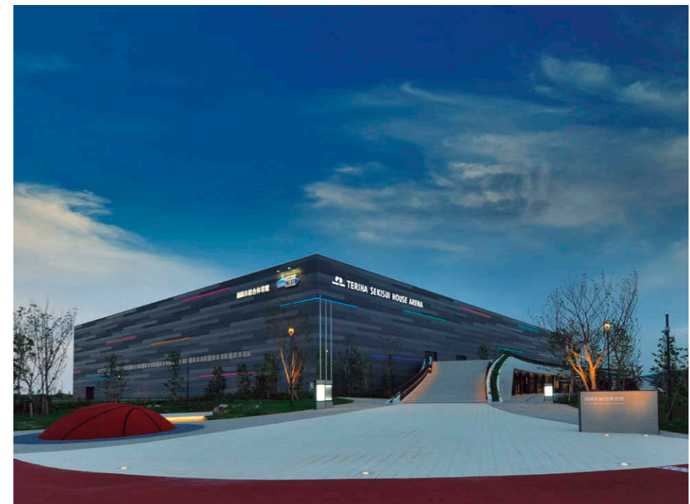
壁面に配置されたフルカラー LED 照明⑥により多様な演出が可能。
