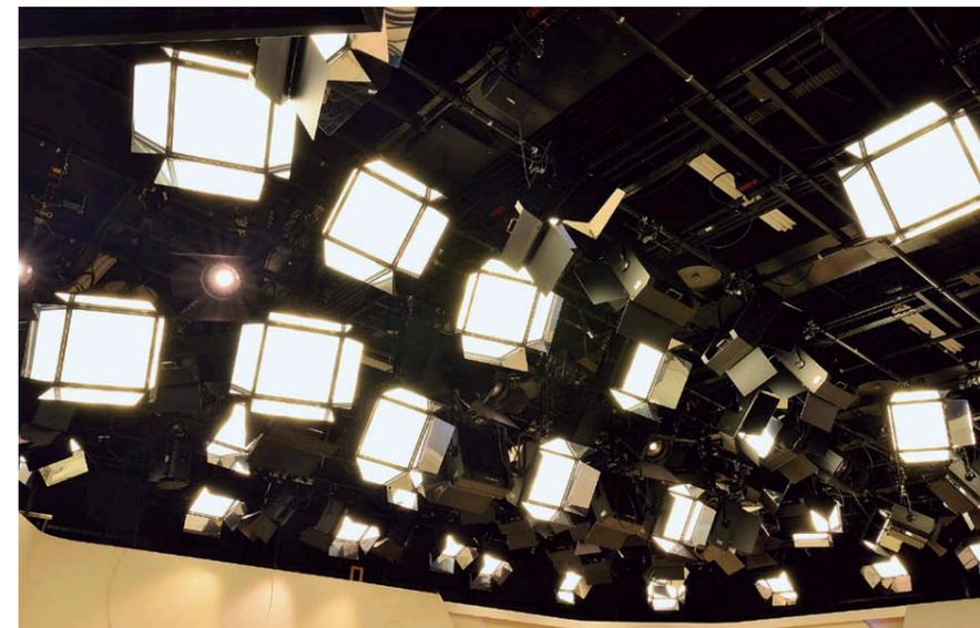
Aスタジオのグリッドパイプ バンドア内面を鏡面仕上げとした高演色タイプのLEDブロードライト①を配置。ワンタッチで撮影が可能な照明環境に。
