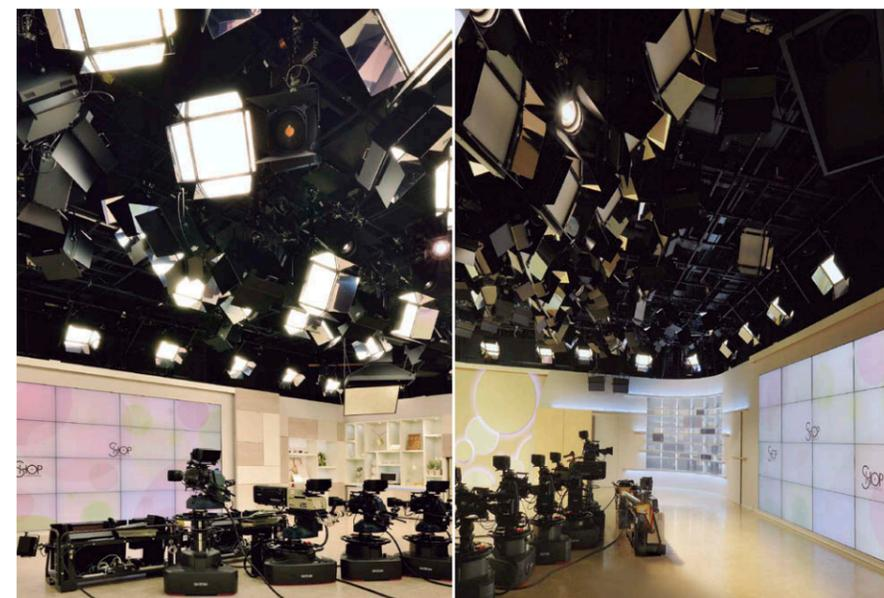
通常撮影時の照明(左)とジュエリー撮影時の照明(右) 通常撮影時はLEDブロードライト①の光を基準に構成。ジュエリー撮影時はLEDスポットライト②の光を効果的に使用し、ジュエリーの輝きを表現。
