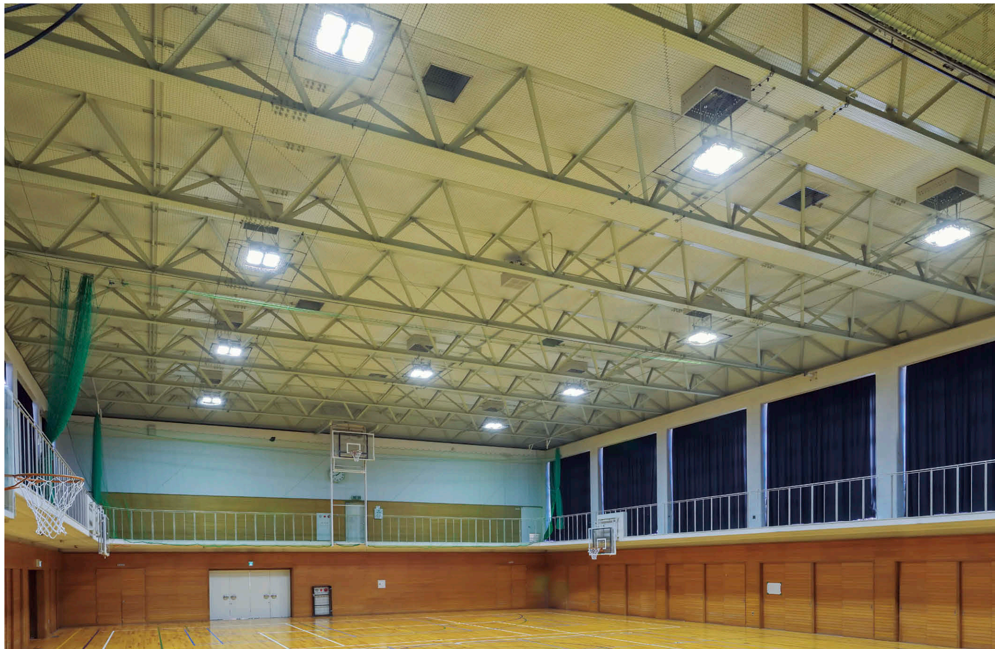
広角タイプの① LED 高天井器具により、高い均斉度を確保。
