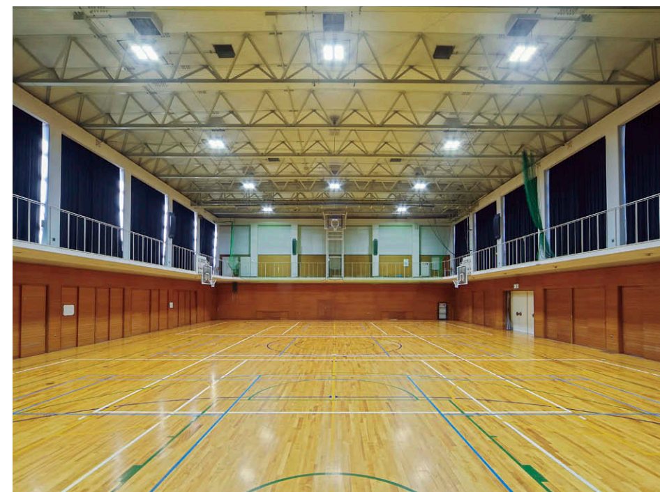
広角タイプの① LED 高天井器具により、高い均斉度を確保。
