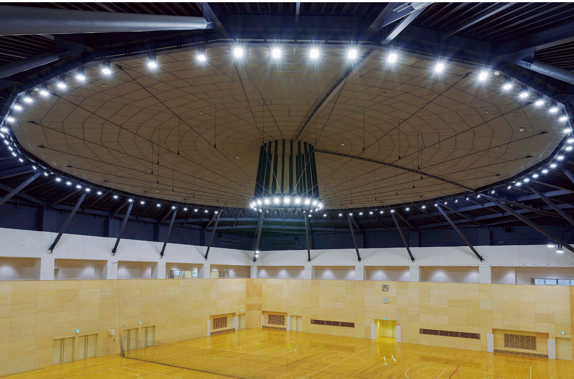
1～2階吹抜のメインアリーナを2階通路から望む LED高天井器具を円形状に配置①
