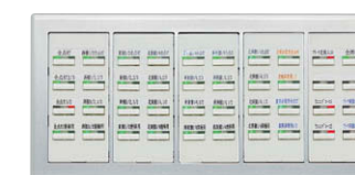
点灯制御盤壁スイッチ
