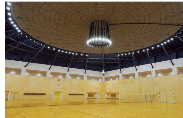
全点灯時の LED 高天井器具による照明①
