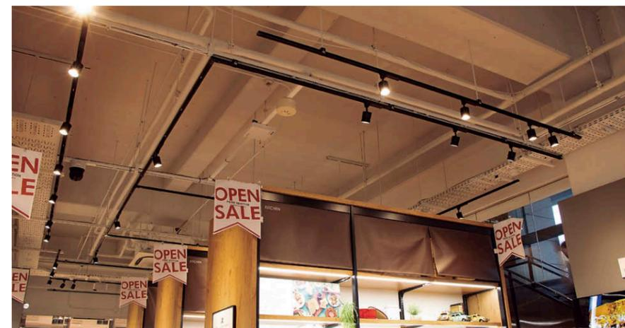
1階ライティングレールに配置したLEDスポットライト①②で各什器に対して個別に照射することで、商品とそれ以外に明るさのメリハリをつけて、商品への視線誘導効果を高めている。
