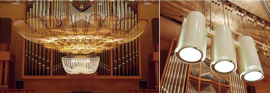
LED シアターシリーズ 電球システムに更新のシャンデリア① 特注 LED ペンダントライト②
