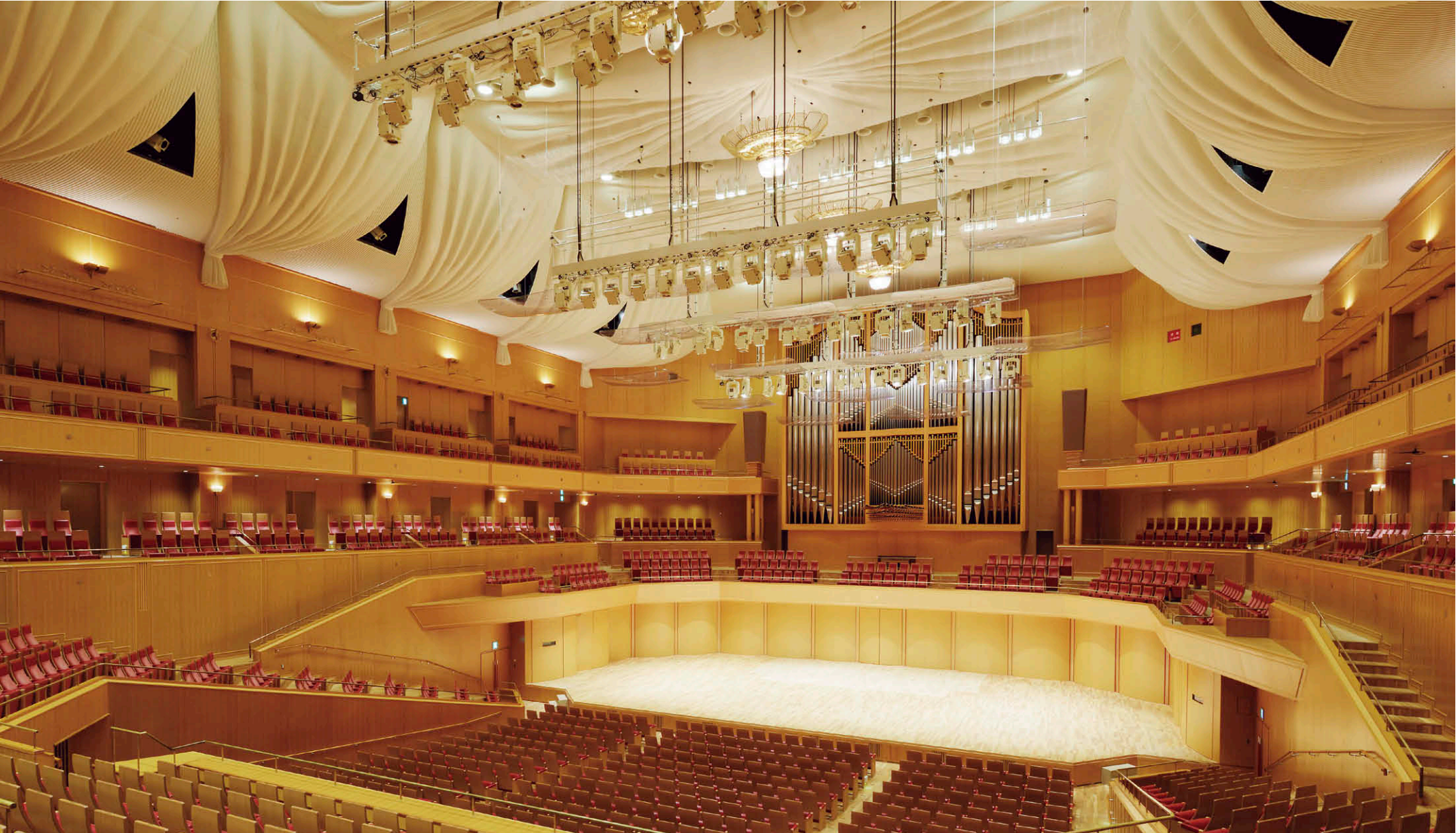
コンサートホール 天井には 7 基の LED シアターシリーズ 電球システム使用のシャンデリアの他、LED ペンダントライト、LED リモコンスポットライト等を配置。 ①②③④
