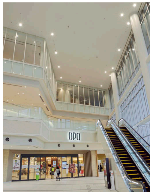
2階カフーナプラザ 400Wメタルハライドランプ器具相当のLED一体形ダウンライト①により明るい照明環境を実現。
