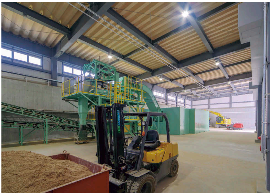
H鋼に均等配置 天井高さ10m
