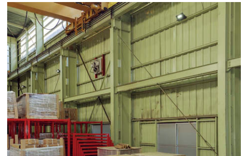
日照が入らない奥の壁面に設置したLED投光器 ③
