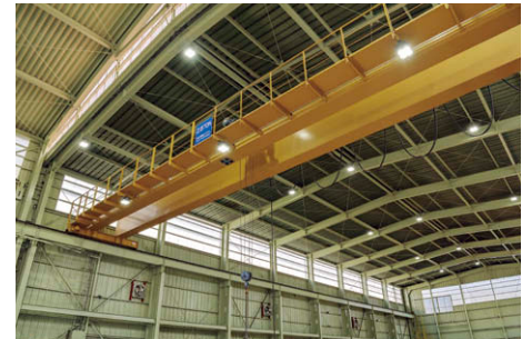
耐衝撃・対振動対応のクレーン用LED高天井器具を手前に天井面を望む ①②
